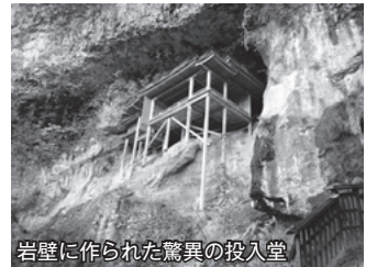
岩壁に作られた驚異の投入堂
