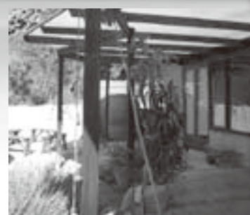
パーマカルチャーを実践している手作りの家には雨水を蓄えるタンクがあり、排水はろ過され庭の植物に与えられている。
